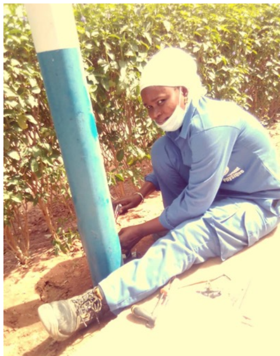
Photo 26 : Yandé S. installation de réverbères solaires à l'Université Assane Seck (crédit : photo personnelle)
